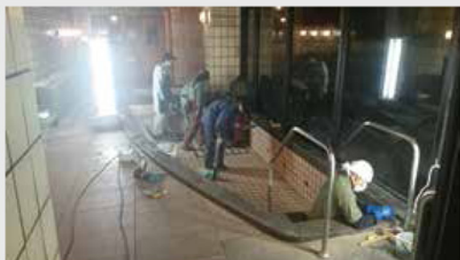
施工作業風景
